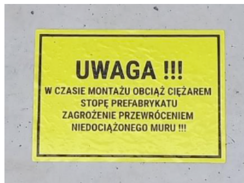
Rys. 4. Naklejka na stopie muru informująca o konieczności dociążenia.
