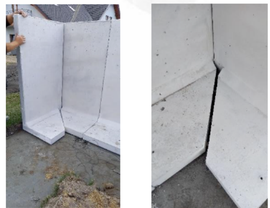
Rys. 5b. Narożniki murów ogrodzeniowych
