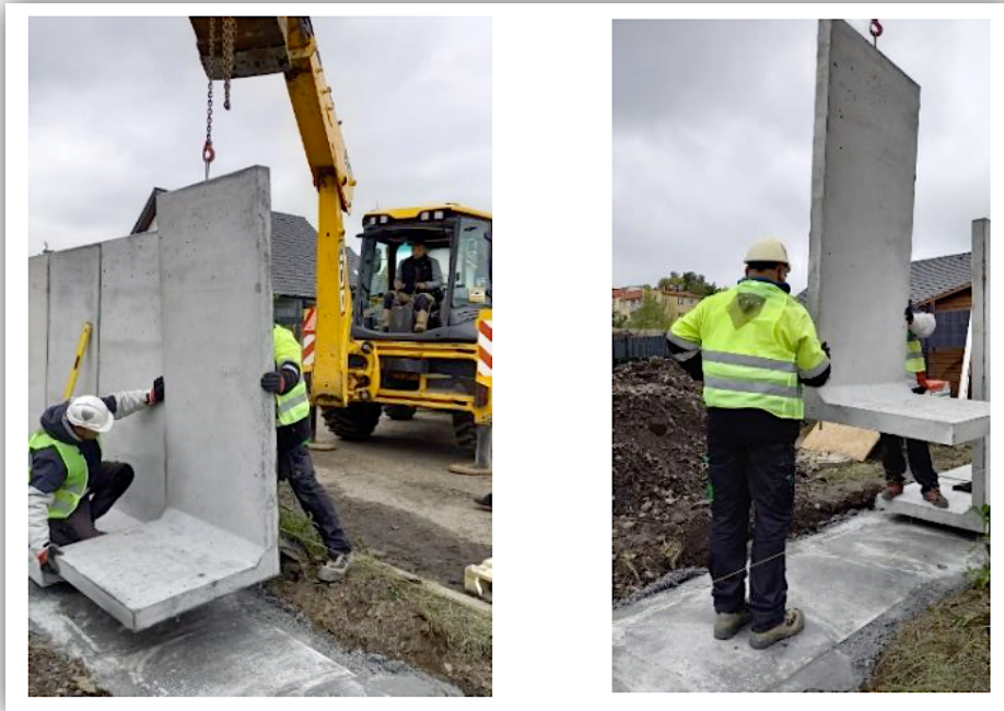
Rys. 1. Początek układania murów ogrodzeniowych na przygotowanym podłożu.
